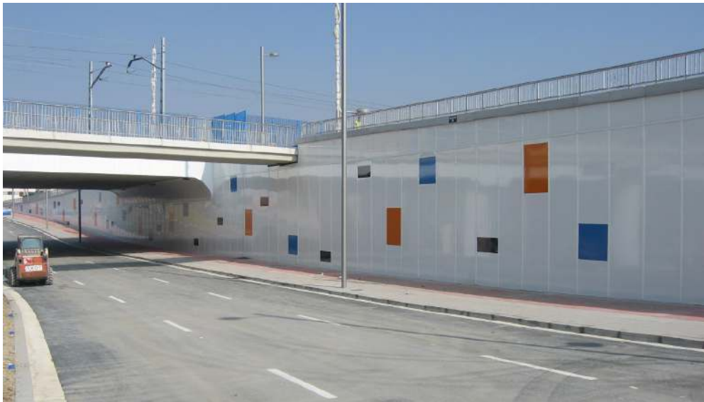
Imagen 7. Ejemplo de revestimiento con acero vitrificado en un paso inferior soterrado
