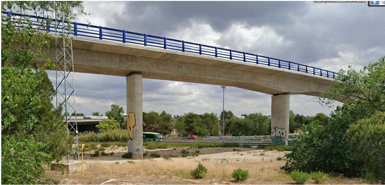
Imagen 37. Pilas afectadas por la inclusión de los nuevos ramales
